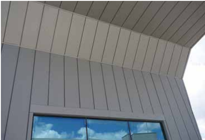
VMZ Interlocking Sistem - Dilovası Miosb Giriş Kapısı, Gebze
