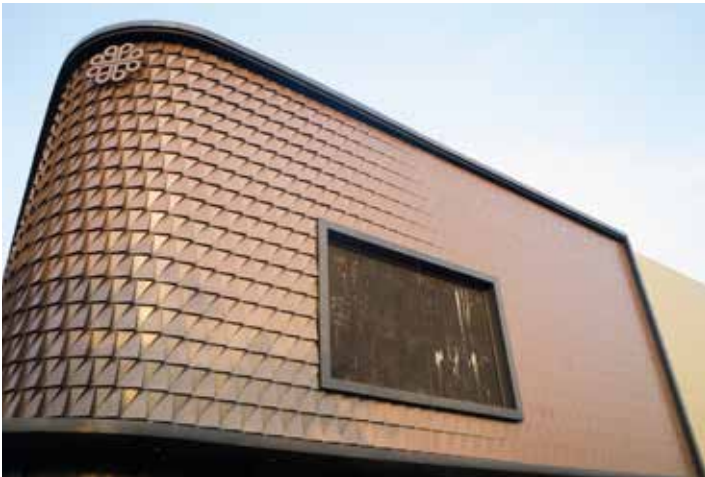
VMZ Interlocking, özel bükümlü şaşirtmalı kabuk, PIGMENTO® Ağaçkabuğu
