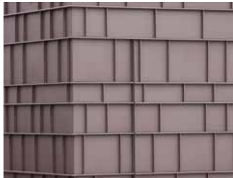
Düsey, yatay ve şaşırtmalı kenetler
