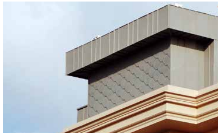
İncirli Paşa Apartmanı Bakırköy, İstanbul
